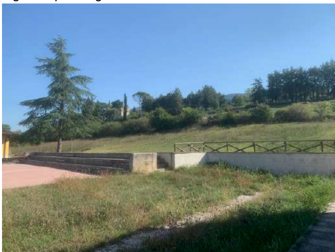
Fig.9. Sopralluogo stato di fatto Area nr.1
